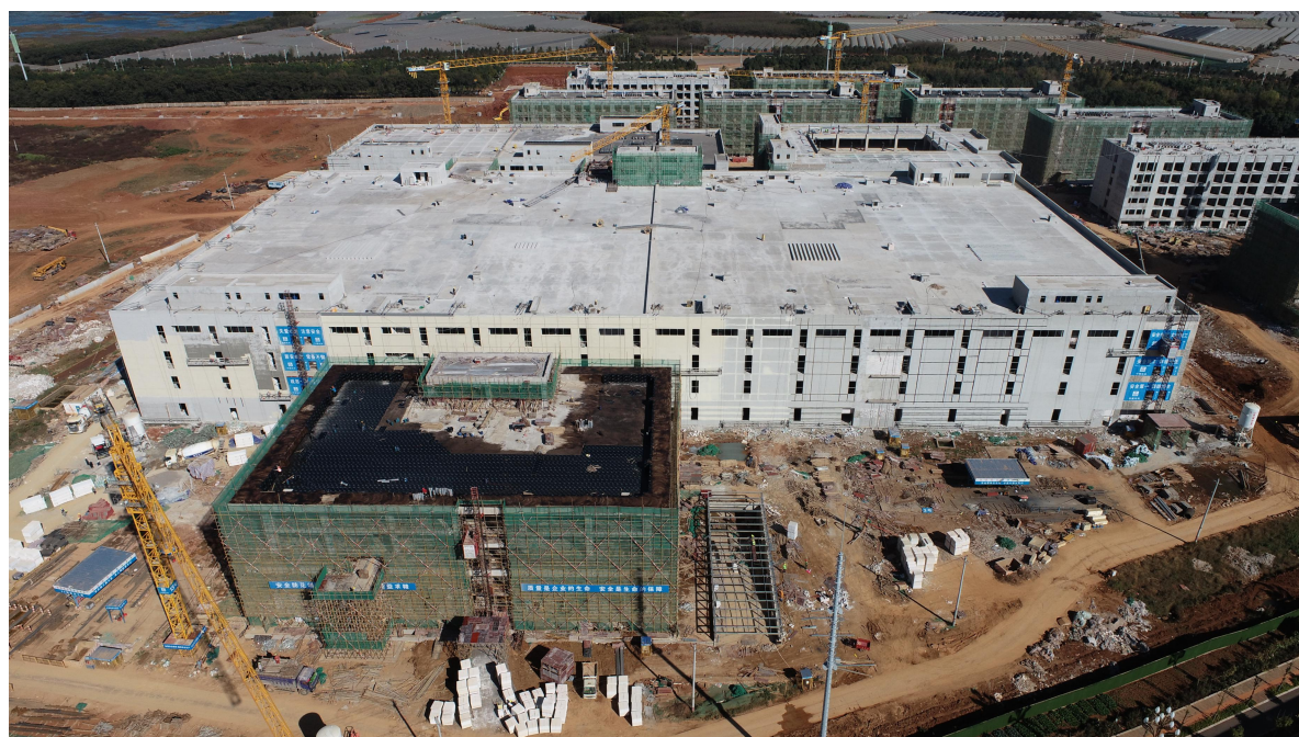
项目建设现状图
