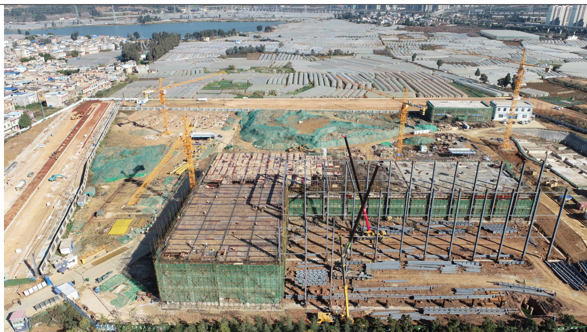
项目建设现状图
