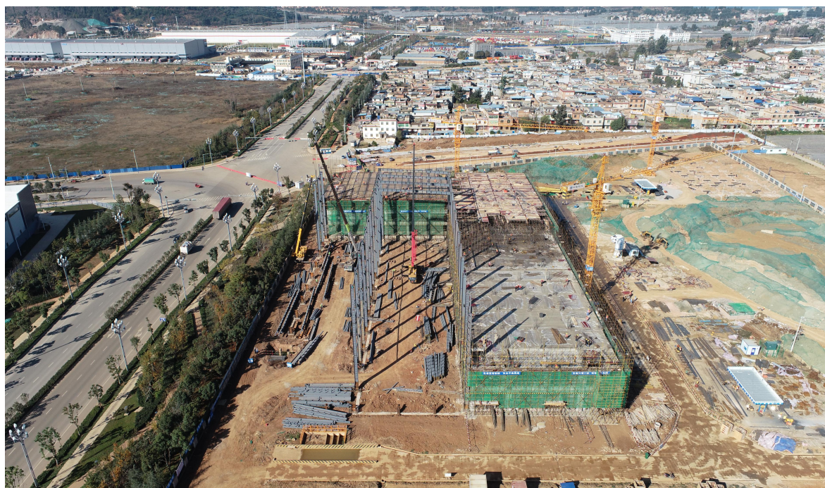
项目建设现状图
